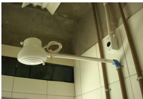
Chuveiro e instalação hidráulica
